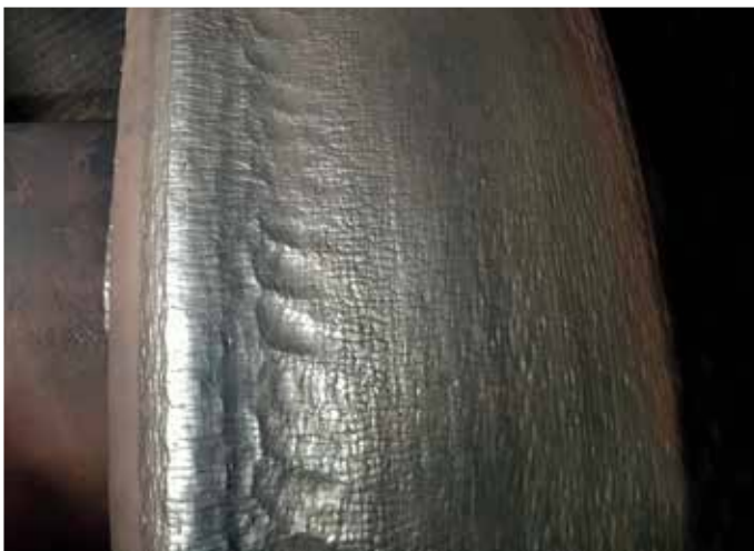
Herkömmliche Lösung nach 18.000 Betriebsstunden
