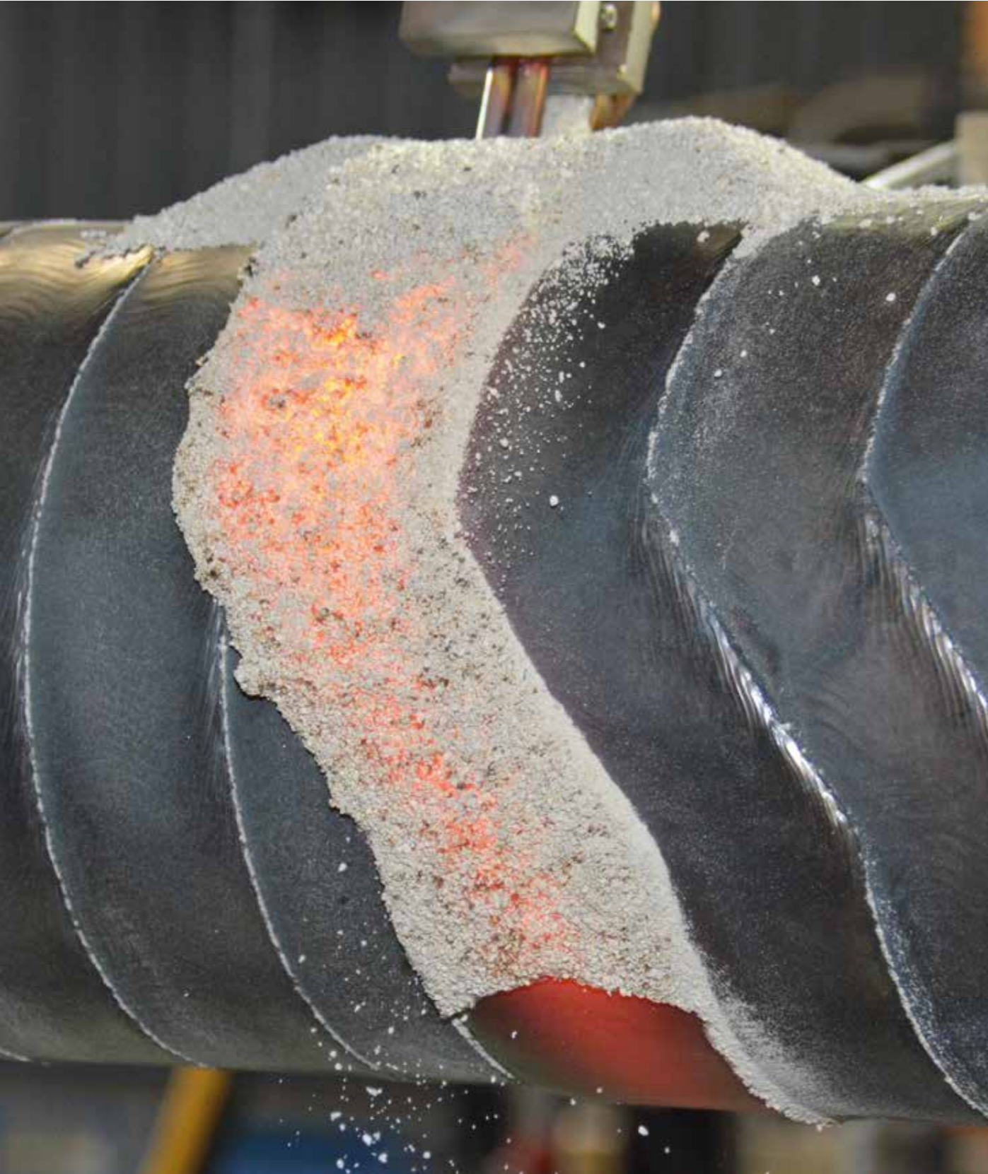
Aplicación automática de revestimiento inoxidable utilizando nuestra máquina de soldadura Roll Cladder y nuestros alambres tubulares de arco sumergido CHROMECORE.
