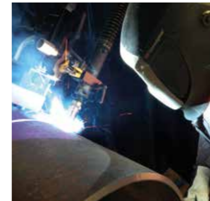
ROBOFIL M 700, soldadura a tope de tuberías desde la raíz hasta la capa de acabado
