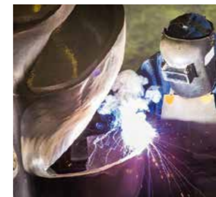
CHROMECORE B 13 4-G, reparación del balde de turbina hidráulica Pelton
