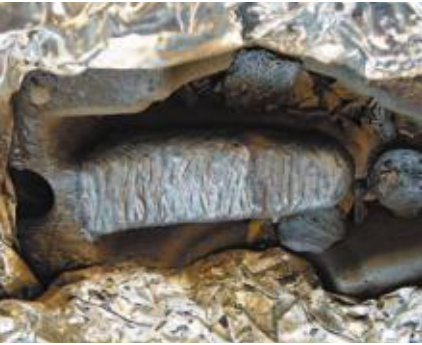
Couverture de la zone rechargée afin de diminuer le rayonnement thermique
