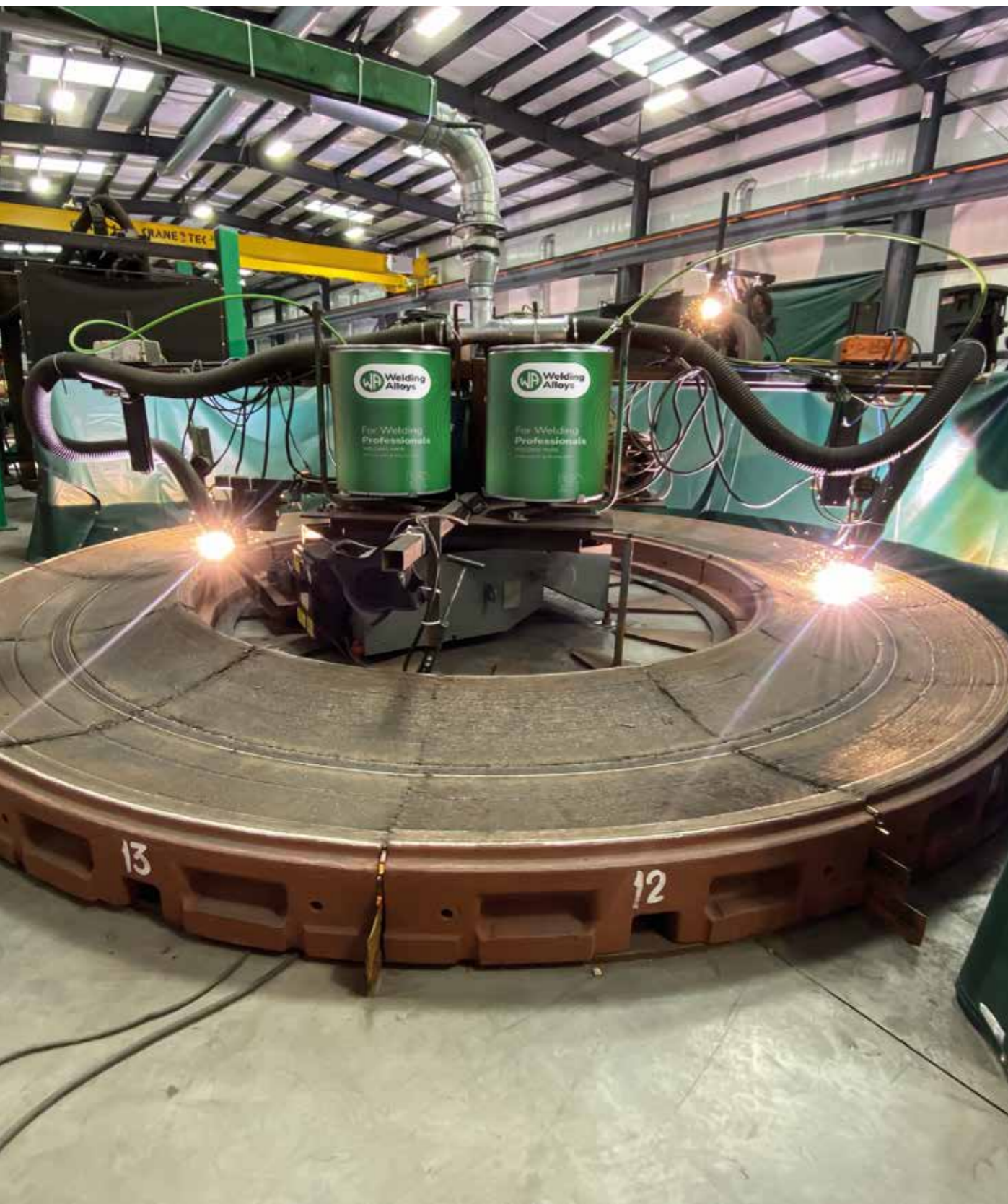
Rechargement d'une table et d'un galet (derrière) de broyeur à ciment avec un dépôt de fonte à haute teneur en chrome
