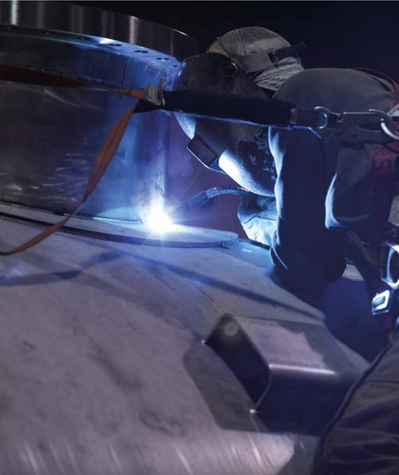
Saldatura di piastra di rinforzo con filo TETRA.
