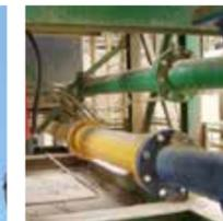
Los componentes que transportan materiales están sujetos a un desgaste altamente abrasivo y erosivo. Nuestros equipos de servicio pueden rediseñar y fabricar nuevas tuberías y tubos, utilizando nuestra gama de placas de desgaste o recubriendo la superficie interna.
